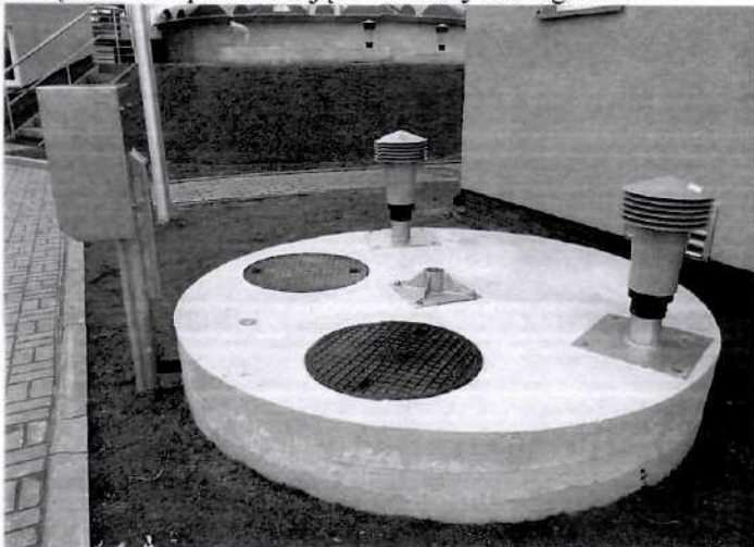
Pompownia ścieków surowych
